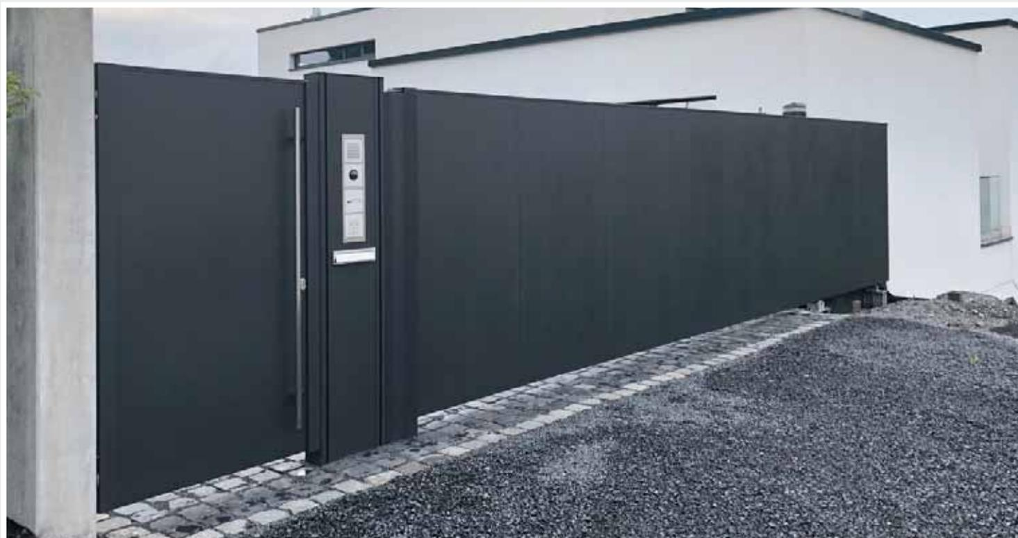
6 m Schiebetor, Glattblech vor die Laufschiene (Typ B8/B9) gesetzt, mit durchgehender Einlaufgabel und Briefkastensäule als Einlauf für Tor und Tür, gerade Abspannung mit Füllung und eingebauter Durchfahrtsbeleuchtung
