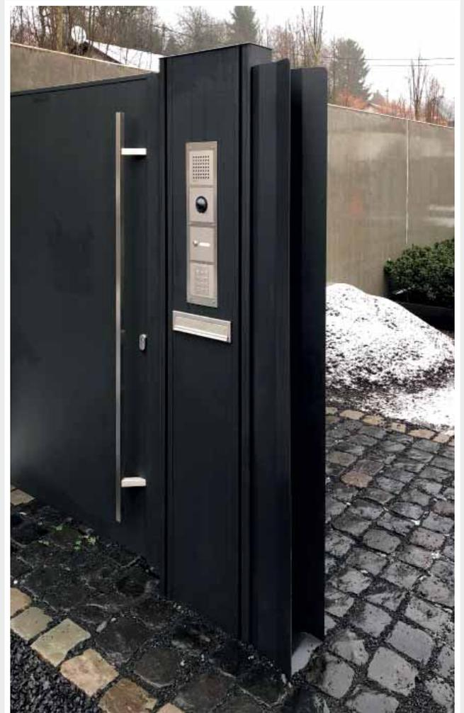
Briefkastensäule mit durchgehender Einlaufgabel als Einlaufpfosten vom Schiebtor und Gehrtür, Oberfläche Tiger Carbon
