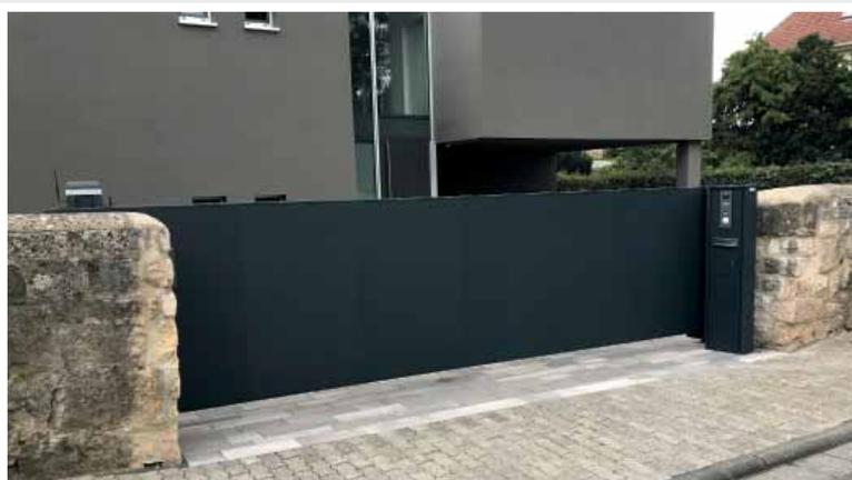
7 m Schiebetor Glattblech vor die Laufschiene (Typ B9) gesetzt mit vorgesetzter Briefkastensäule und Entnahmetür vorne
