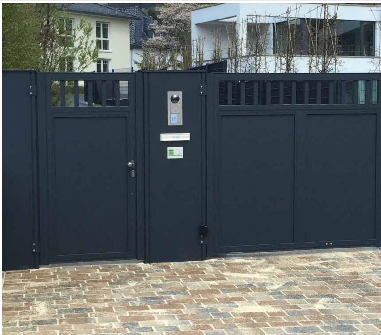
3,86 m Drehtor 2-flügelig, Glattblech mittig im Rahmen (Typ B1), oberhalb Profil 40/30, RAL 7016 Feinstruktur, Bedien- und Briefkastensäule als Halte- und Anschlagpfosten mit Anschlussür
